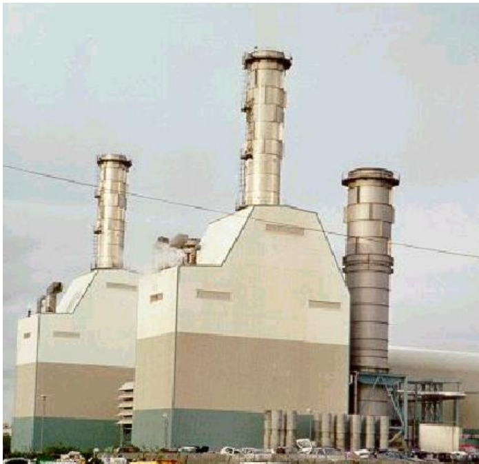
Figure 6: Two HRSG Units at Peterborough CCGT
